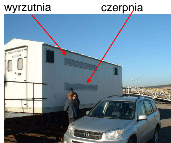
Rys. 4 . Wentylacja „przez plecy” – przykład realizacji na podstawie kontenerowej stacji roboczej ciągu węglowego – odkrywka Drzewce KWB Konin.
